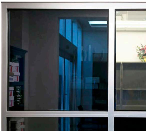
Figura 4. Vidro eletocrómico, com controlo ativo da transmitância ótica.
